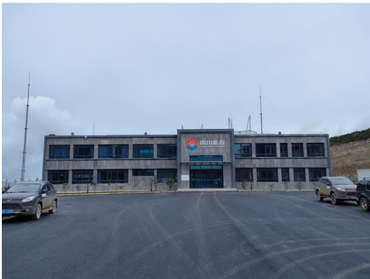
图 1-4 井叶特西 220kv 升压站
