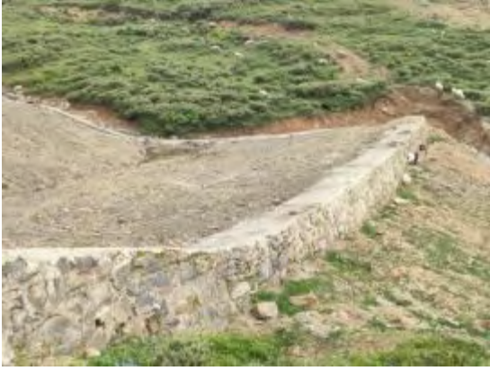
弃渣场工程区浆砌石挡渣墙
