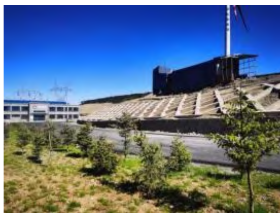
道路工程区框格梁植草护坡
