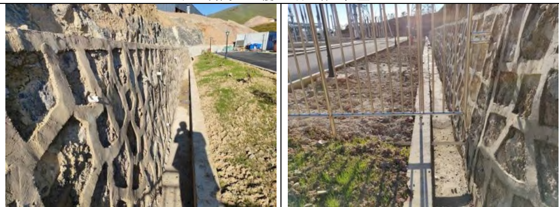
浆砌石排水沟（升压站工程区）
