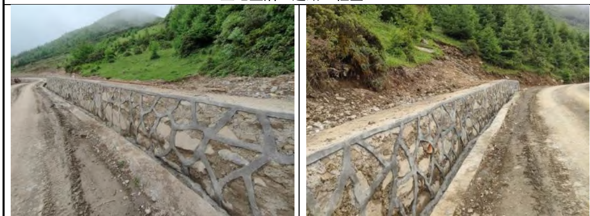
浆砌石护坡（道路工程区）
