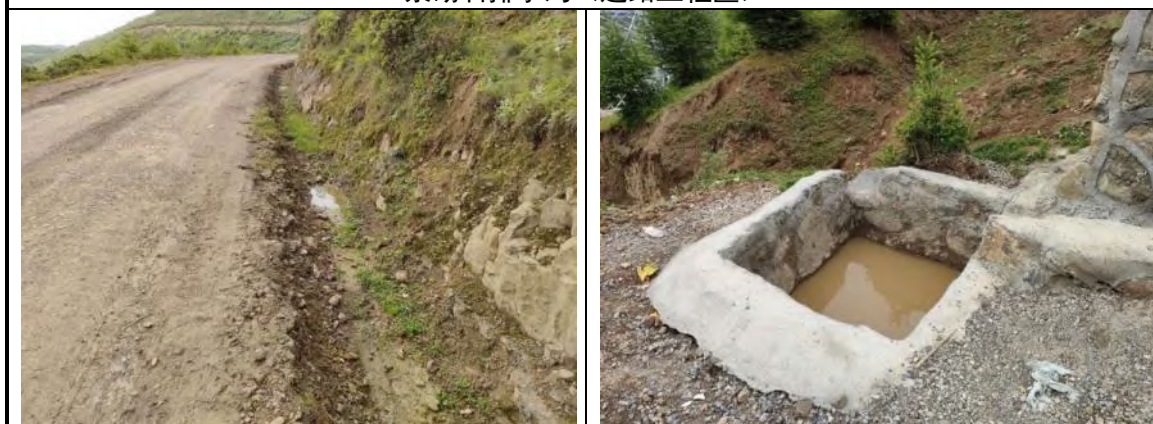
生态排水沟（道路工程区）
