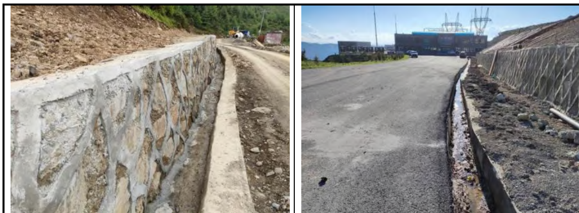
浆砌石排水沟（道路工程区）
