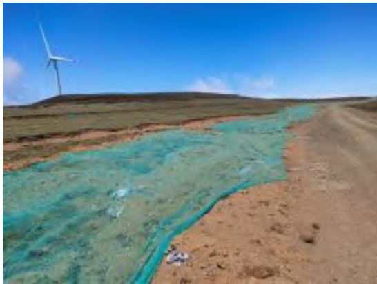
集电线路工程区防尘网遮盖
