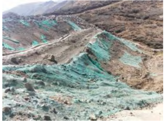
弃渣场区防尘网遮盖
