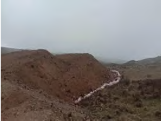
弃渣场区土袋拦挡
