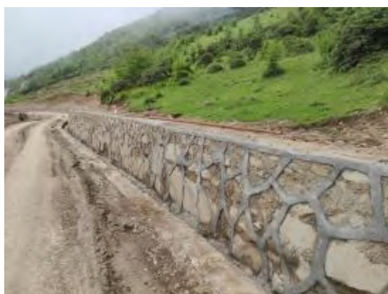
道路工程区浆砌石护坡
